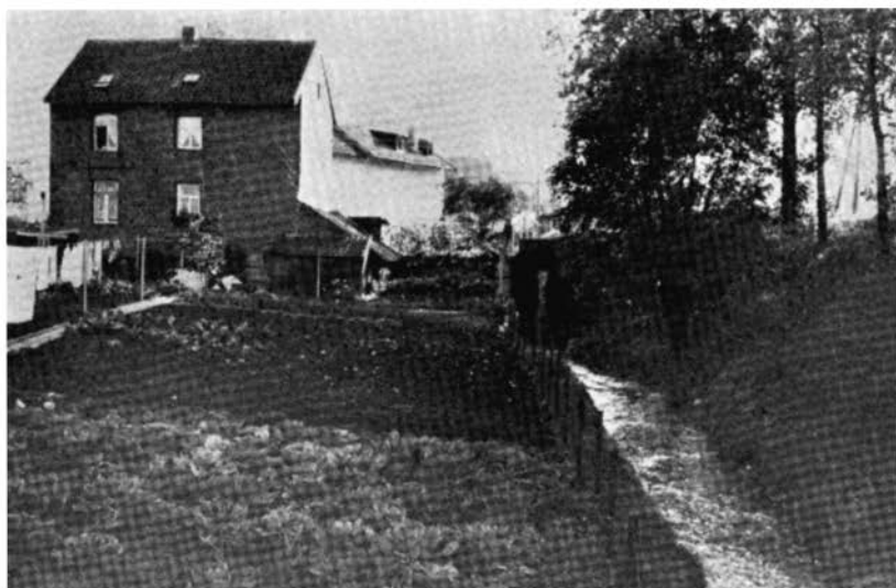
Onderste Caumer, okt. 1962. Uitloop gerioleerd gedeelte van de Caumerbeek met oude molenaarswoning; foto genomen in de richting A-B, zoals is aangegeven op de Situatiekaart.
