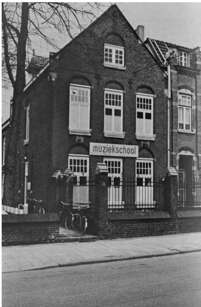
Pand Stationstraat 61: de voormalige onderwijzerswoning van de Openbare Lagere School, die de muziekschool van mei 1940 — november 1943 en daarna sinds 1946 tot heden als „hoofdgebouw” kreeg toegewezen.
