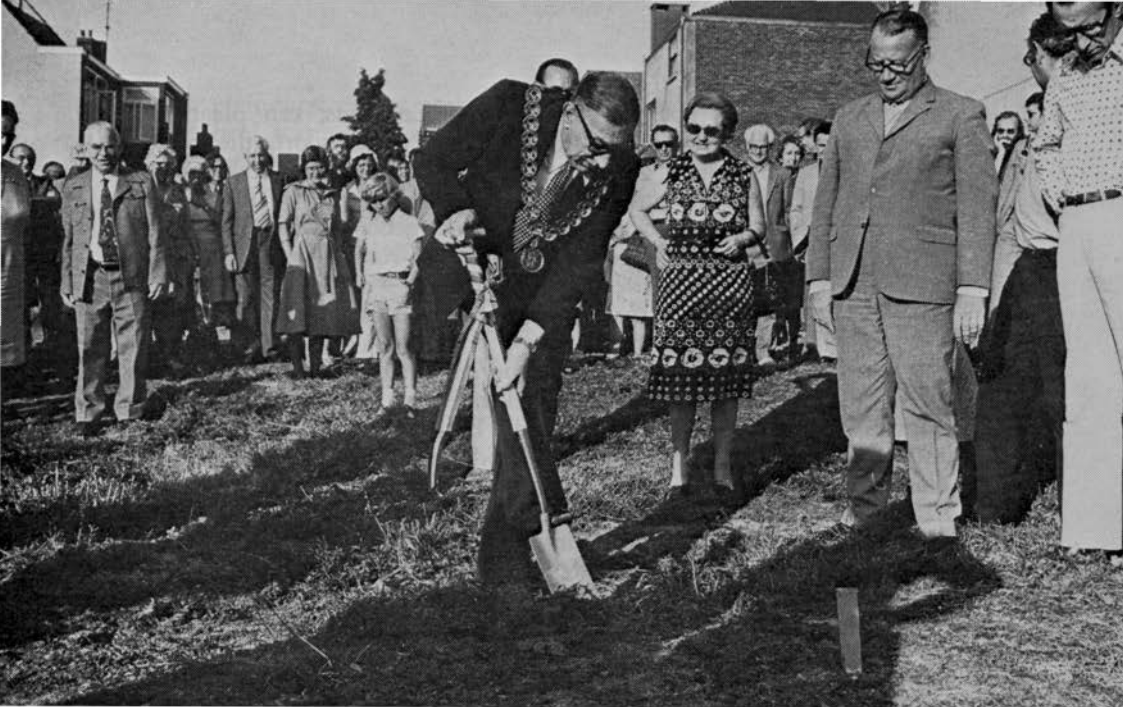
Op 5 augustus 1975 steekt burgemeester Gijzels de eerste spade in de grond voor de bouw van het thermencomplex
