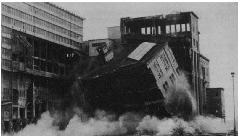
Het opblazen van de wasserij van de Hendrik te Brunssum, 16 juni 1972
