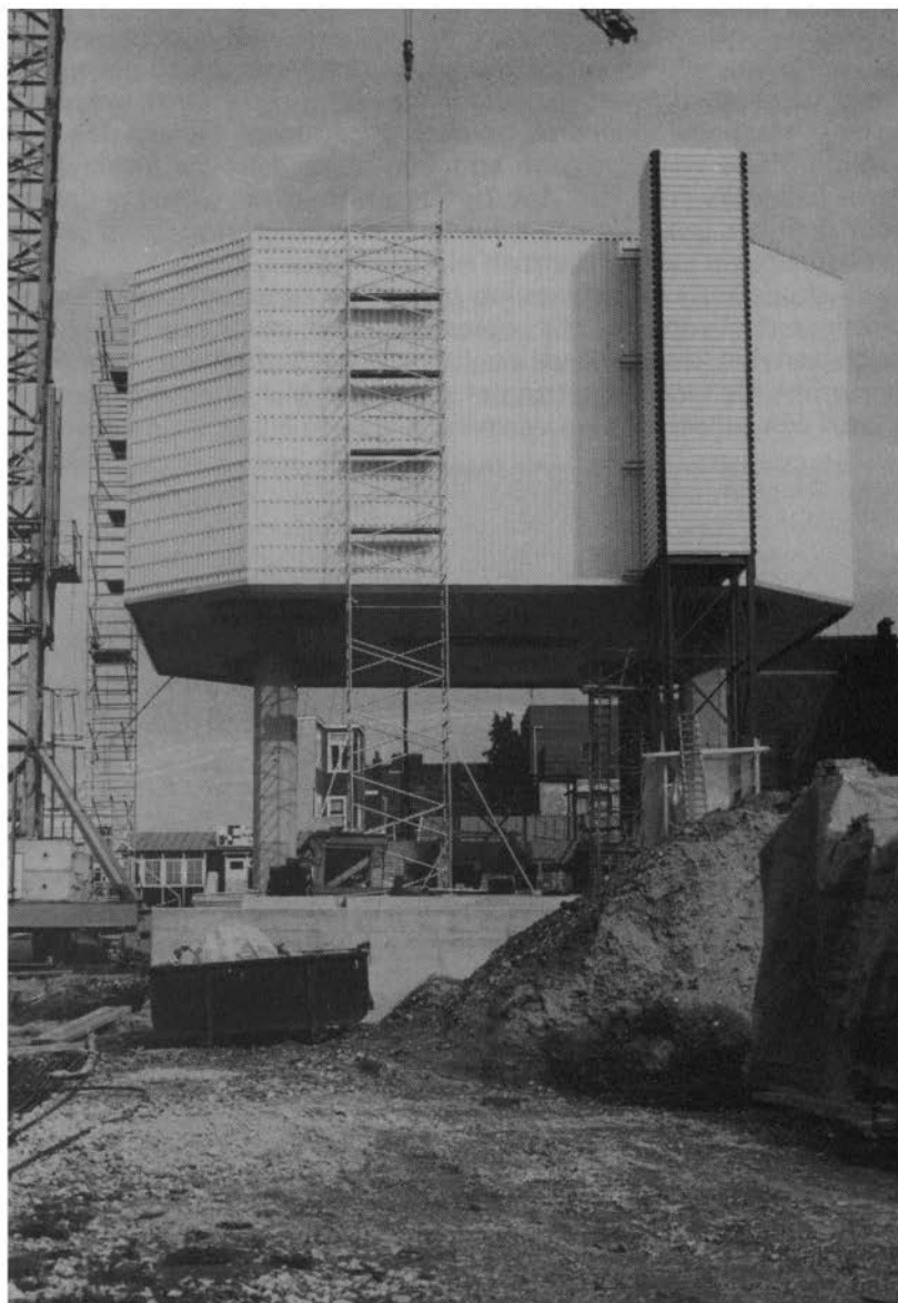
De architectoren voorzien van de beplating (foto oktober 1976)
