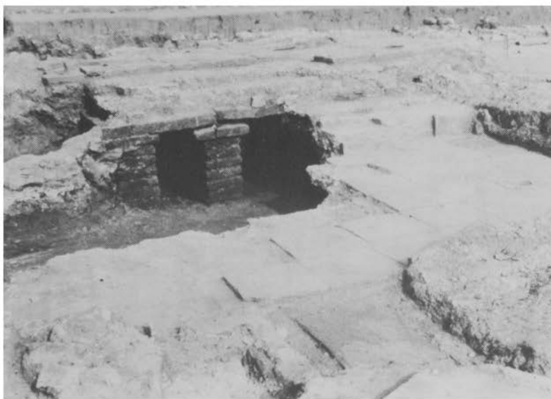
Constructie vloerverwarming badgebouw (opgraving 1947-1950).
