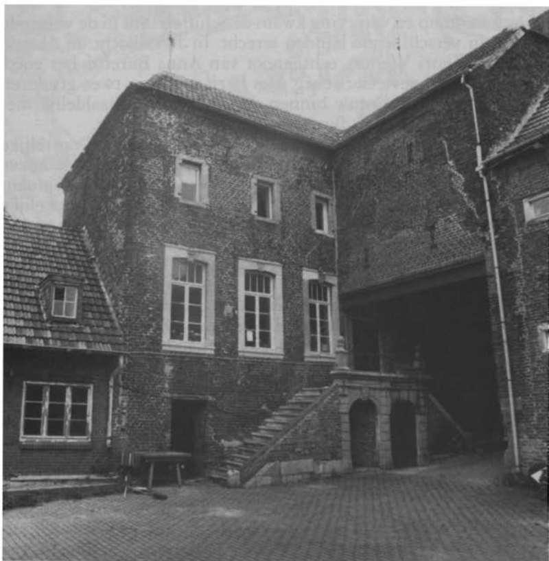
De Schiffelerhof vóór de restauratie (detail) foto: Dries Linssen
