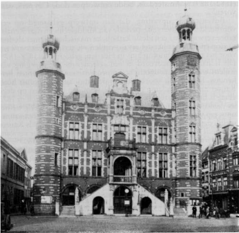
Het stadhuis van Venlo na de restauratie (1879-1885) door J. Kayser.
