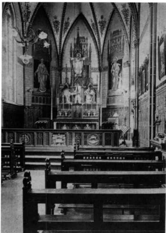
Afb. 9. De kapel van het Savelbergklooster (1878-1879), Gast- huisstraat 45. (foto: collectie Ar- chiefdienst Gemeente Heerlen)
