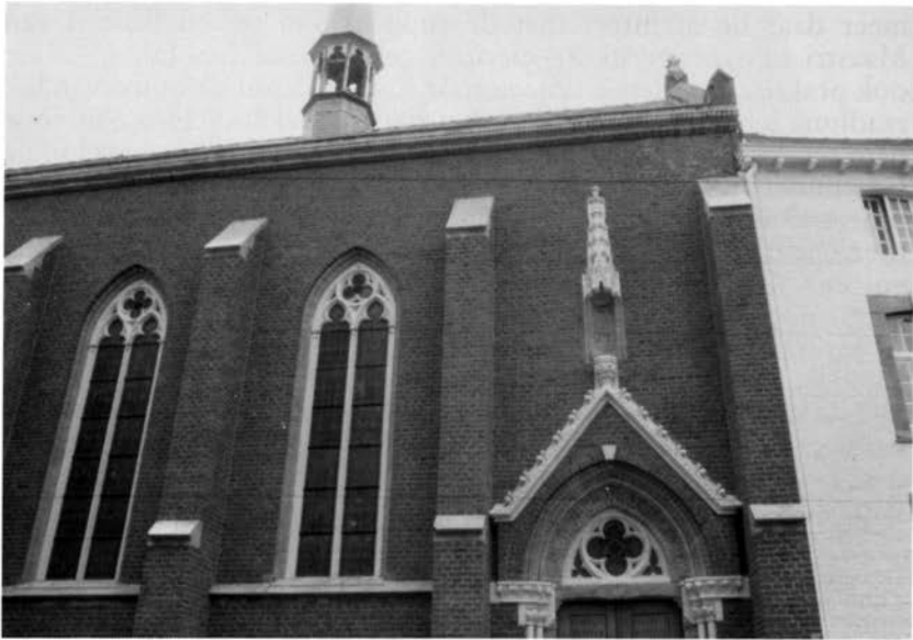
Afb. 6. De kapel van het Savelbergklooster: terracotta profielsteen in de daklijst en de vensterlijsten. De traceringen in de vensters zijn klassiek gotisch. (foto: collectie Archiefdienst Gemeente Heerlen)
