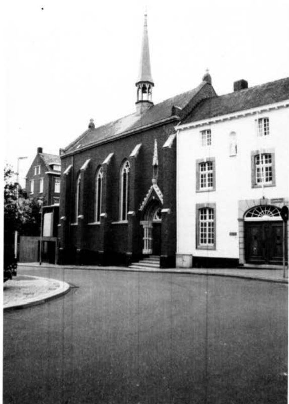
Afb. 1. De kapel van het Savelbergklooster (1878-1879), Gast- huisstraat 2. (foto: collectie Ar- chiefdienst Gemeente Heerlen)
