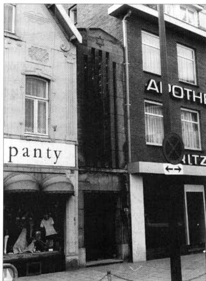
De ingang van de synagoge aan de Stationstraat. (SAH, fotocollectie nr. 3379)
