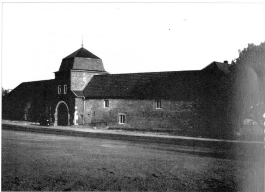
De kasteelhoeve Passart-Nieuwenhagen na de grondige opknaptbeurt in 1994-1995
