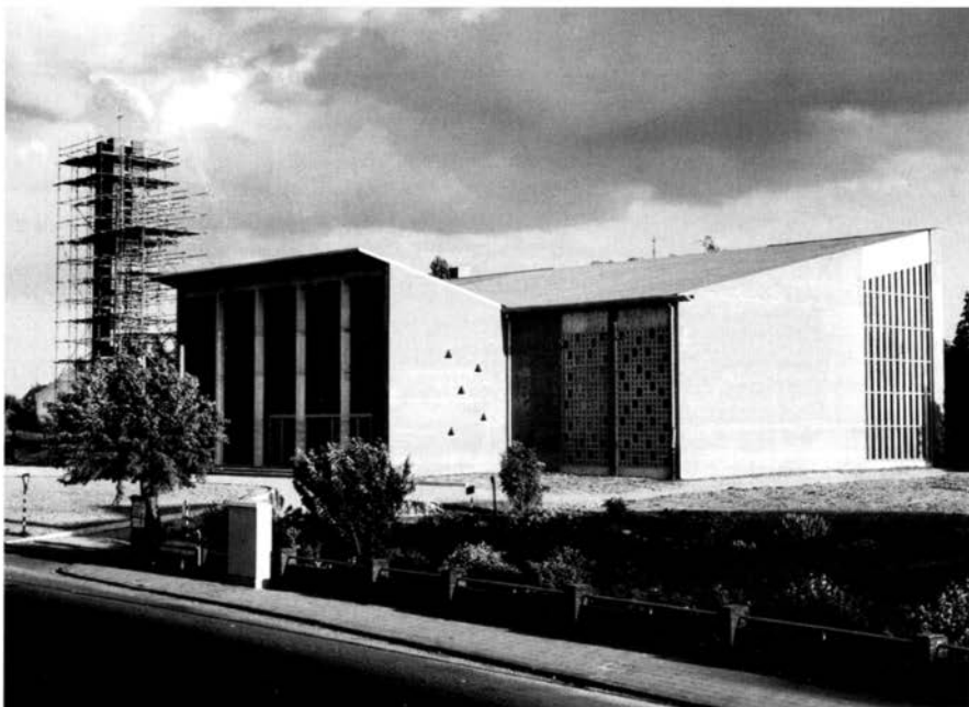
De nieuwe kerk van Mariarade in aanbouw.
