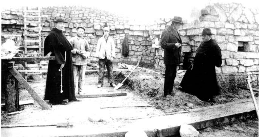
De bouw van de Lourdesgrot in 1929.
