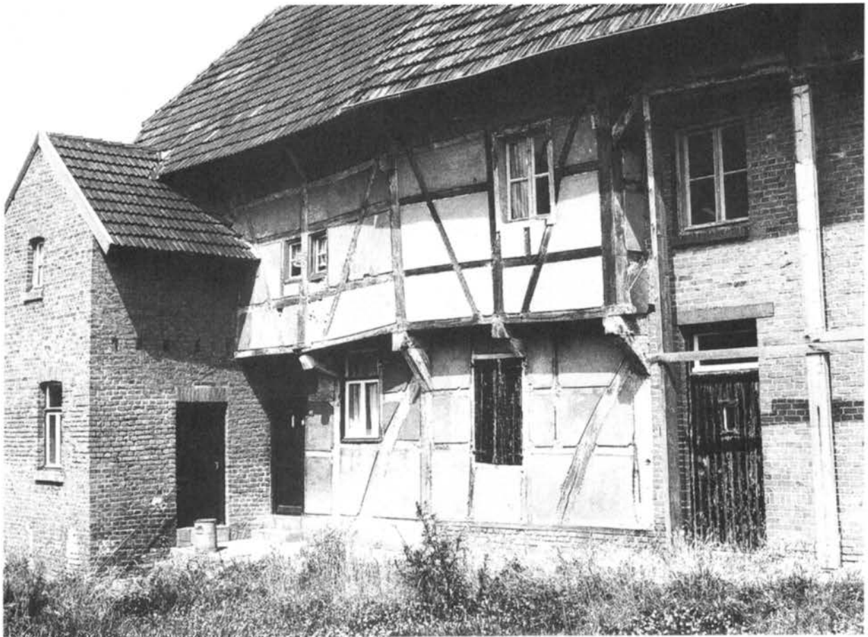
De Horricherhof in 1975 vóór de restauratie.
