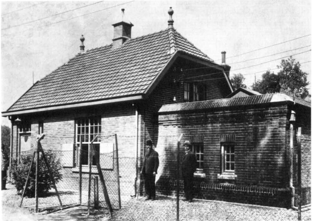
Pompstation Caumer met links directeur Pel van het waterleidingbedrijf. Vooraan bij het hek de kraan waar de buurtbewoners van de Caumer gratis water konden halen.
