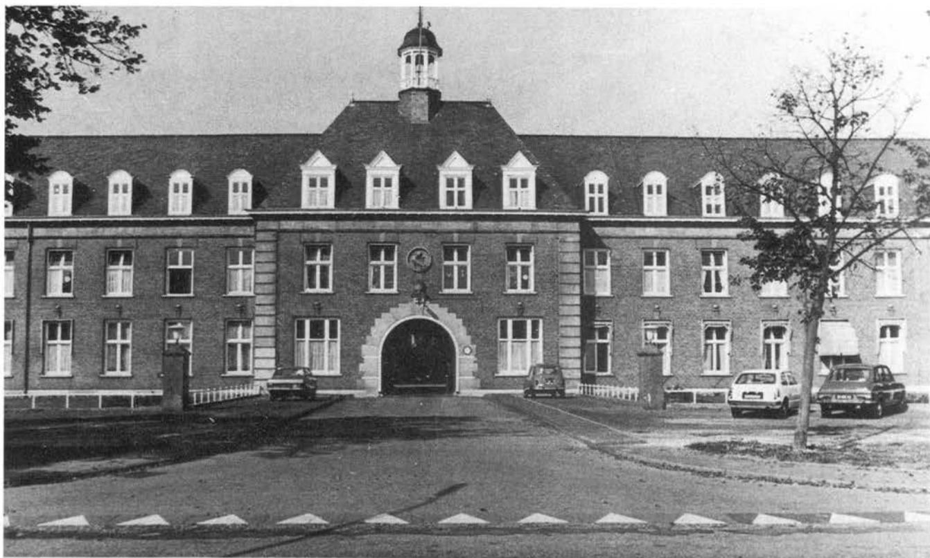
Voormalige Vroedvrouwenschool uit 1920, ontworpen door architect Jan Stuyt.
