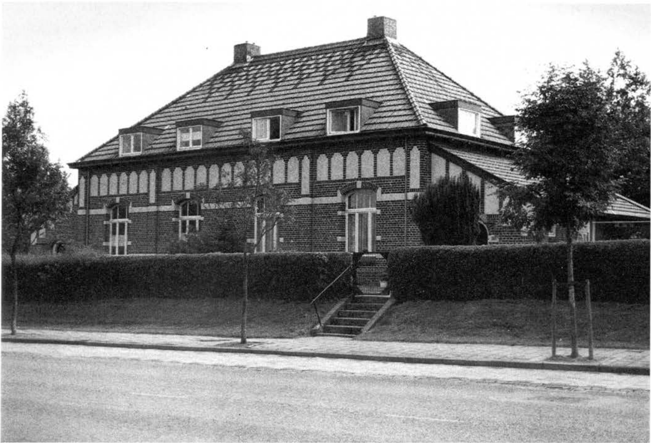
Mijnwerkerswoningen aan de Sittarderweg. Bij selectie voor de monumentenlijst heeft men getracht van elk soort woning één of meerdere exemplaren te bewaren.
