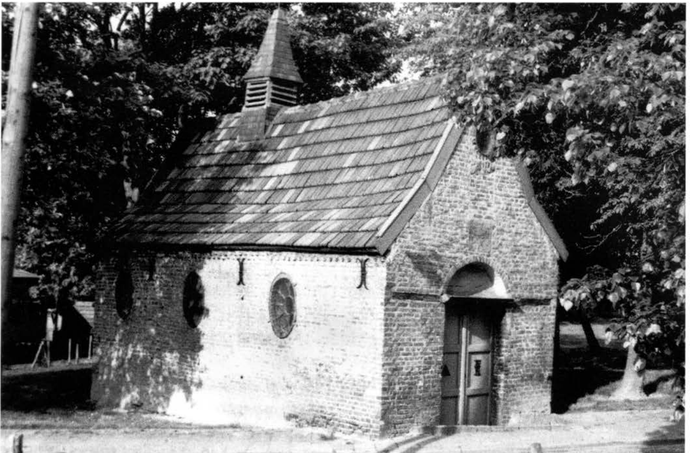
Barbarakapel aan de Slotweg. In 1670 gesticht door de toenmalige heer van Schaesberg, Johan Frederik, in de 18de eeuw vergroot en in de 19de eeuw gewijzigd. De gevels laten diverse sporen zien van dichtgemetselde ramen en ingangen.
