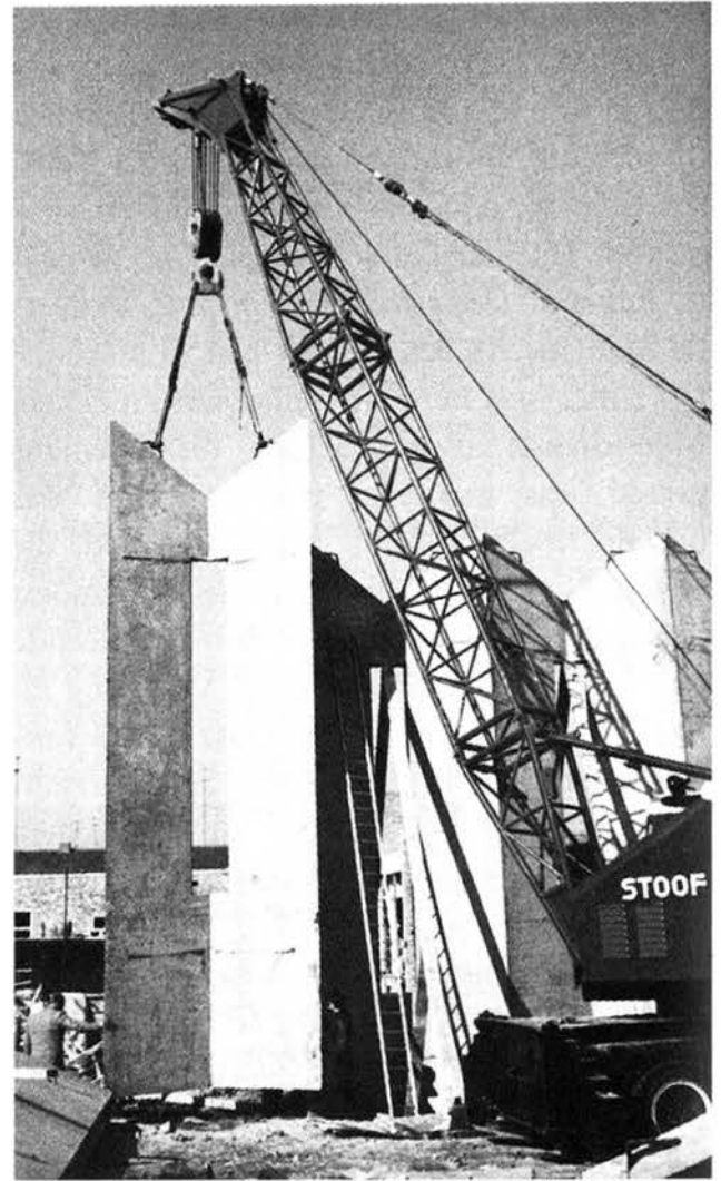
Het stellen van de wandelementen in de funderingsgleuf.
