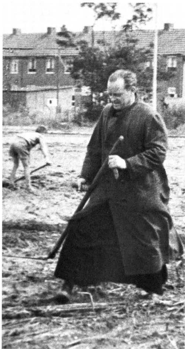
Bouwpastoor Frencken aan het werk bij het egaliseren van het bouwterrein.
