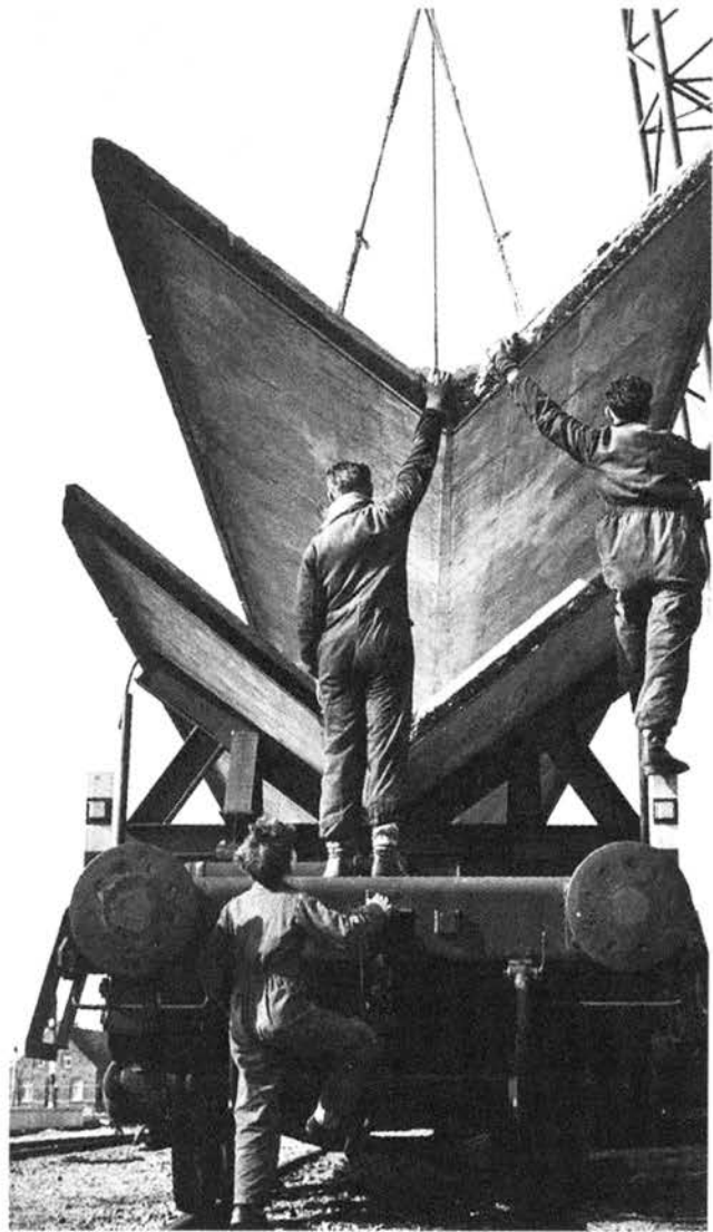
Het verladen van de betonnen prefab-elementen.
