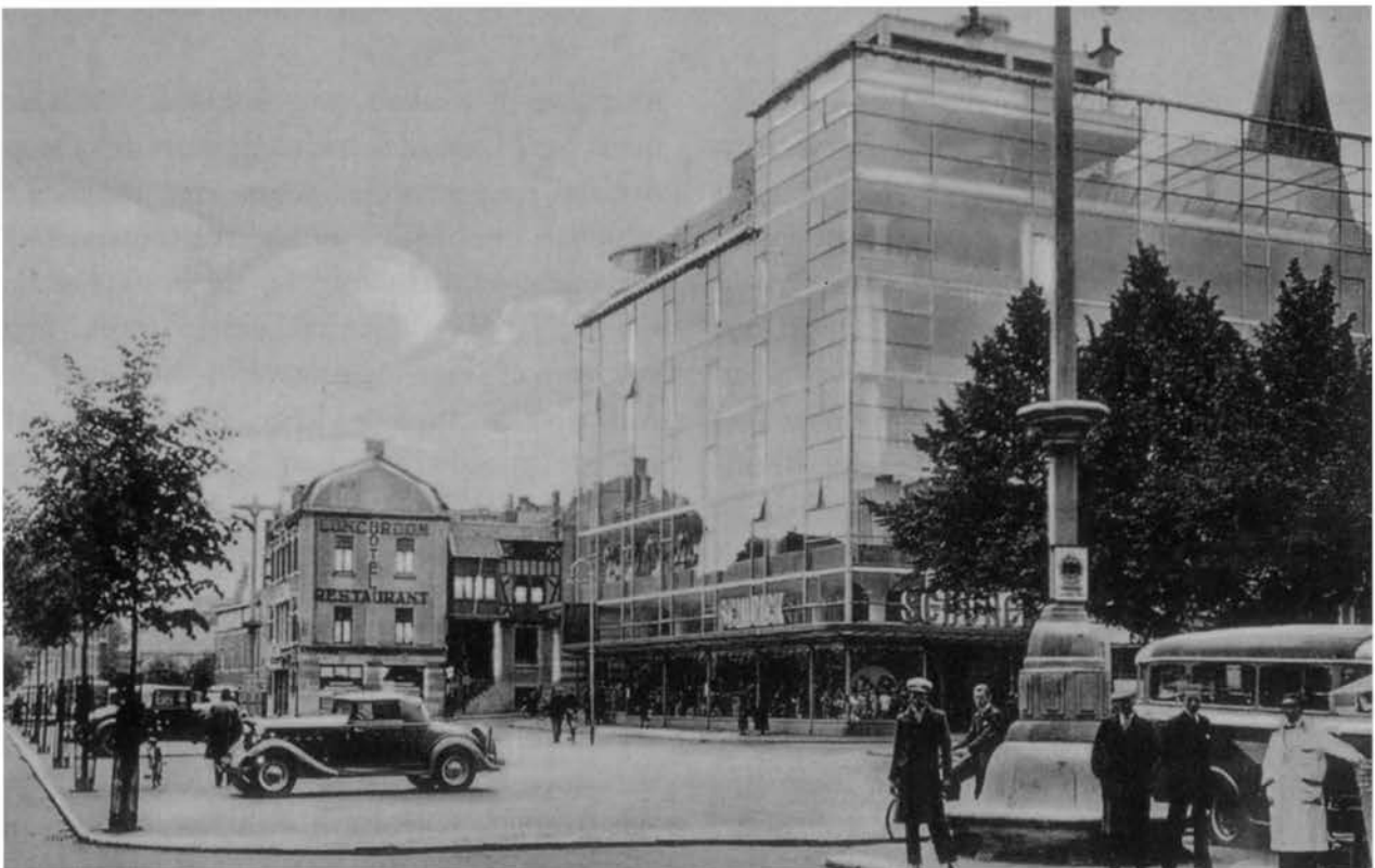
Het glaspaleis in de jaren dertig. Parkeren voor het gebouw was toegestaan.
