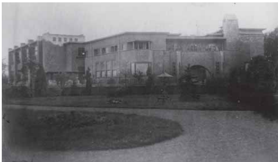
Het klooster aan de Scharnerweg, opname ca. 1930. Ontwerp Boosten/Ritzen 1922.
