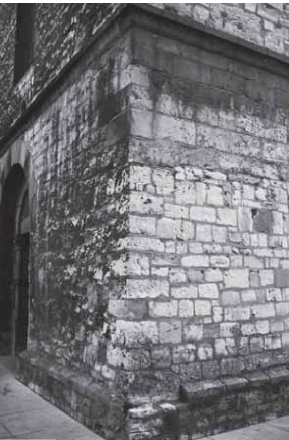
Afb. 3: Gedeelte van de toren met bouwnaad op ca. 2 meter hoogte. foto L. Schiphorst, Heerlen
