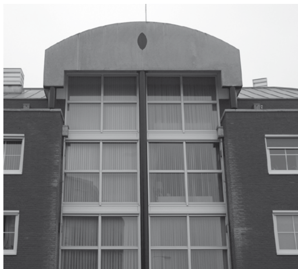
Kerkrade, Poststraat. Postmodern woonhuis met geveltop en gestileerde zuilen.
