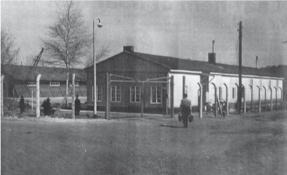
Voormalig strafkamp Nievelsteen. foto: Collectie Eygelshoven door de eeuwen heen
