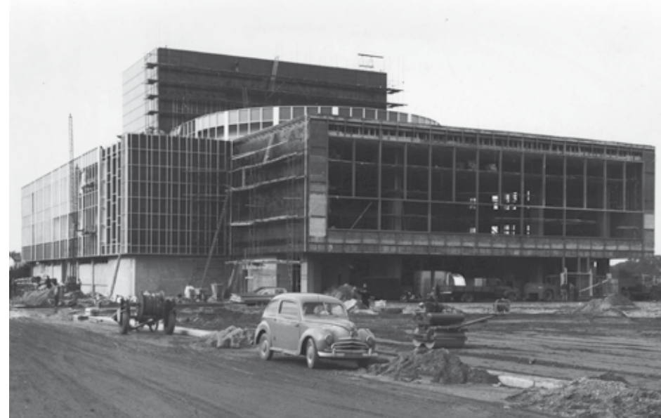
De schouwburg in aanbouw, februari 1961. Zicht vanaf de Geerstraat op de ingang en daarboven de grote foyer. Het hoge deel aan de achterkant is de 28 meter hoge toneeltoren.
