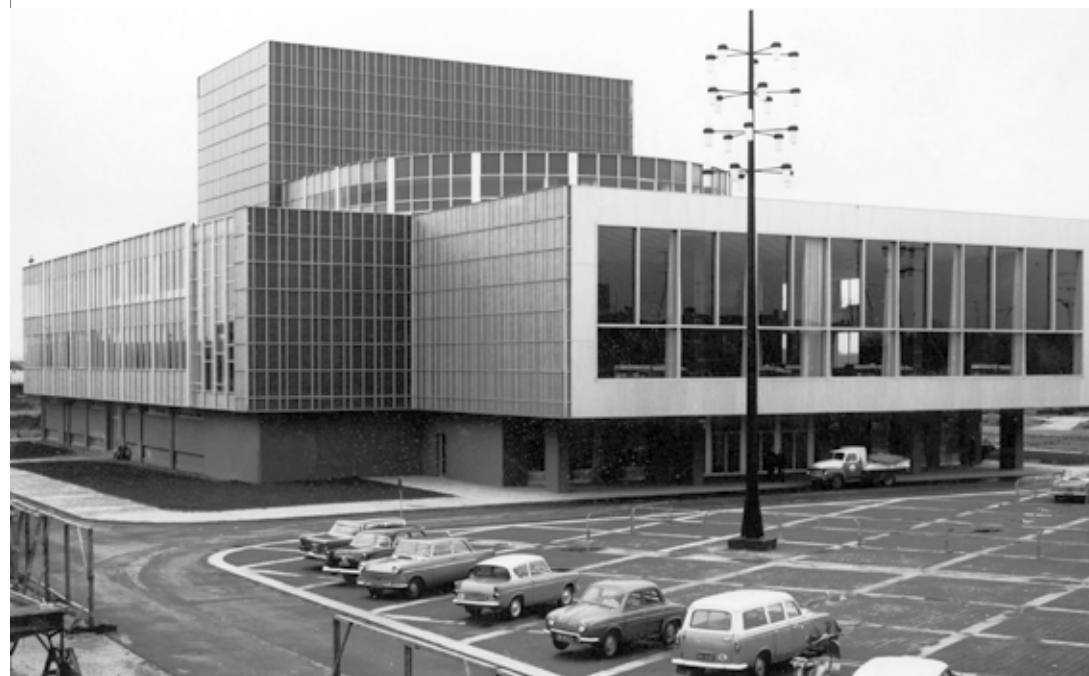
De Heerlens schouwburg, 1962.
