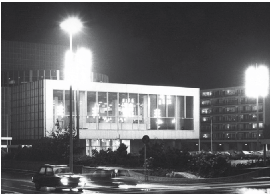
Zicht op de grote foyer van de Heerlense schouwburg.
