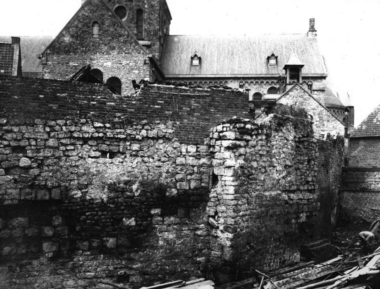
Nog aan het begin van de 20ste eeuw stonden er delen van de vestingmuur overeind (1915). De laatste grote stukken muur hebben eind jaren 1960 plaats moeten maken voor parkeerplaatsen. Foto: Collectie Rijckheyt, Heerlen.
