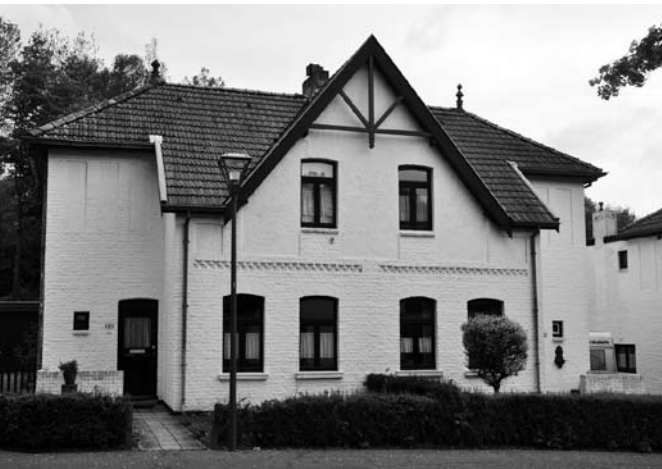
Kerkrade-Hopel, Merelstraat 8 en 6, voormalige mijnwerkerswoningen (A. Reichpietsch).
