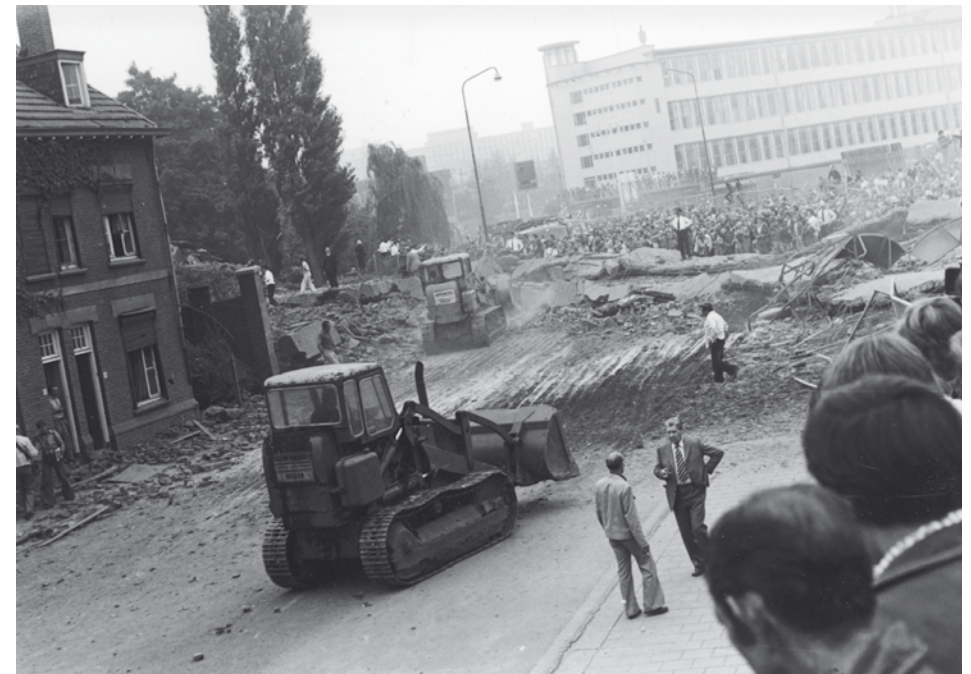
Lange Jan ligt gebroken en geplet over de Kloosterweg. Links de beschadigde huizen van de families Heijmans en Seijben. Achter de bomen stond de villa Freling die door Lange Jans val totaal werd verwoest. Op de achtergrond een nieuwsgierige en opdringerige mensenmenigte.
