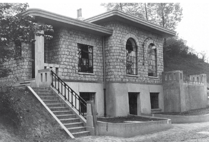
Pompstation Croubeek bij de Zevensprong
