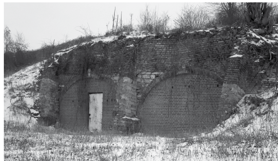
De dubbele oven gelegen geheel boven in het sectie C 318. Het bouwsel is ernstig aangetast door boomwortels en verkeert in een slechte staat van onderhoud, dit in tegenstelling tot het richting de Daalsweg gelegen ovencomplex.
