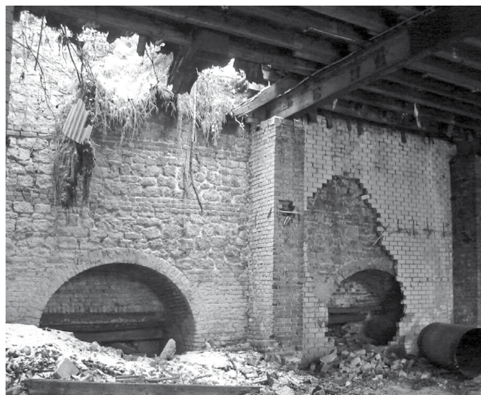
Ruïnes van de restanten van het ovencomplex. Het is waard deze in het kader van het Kalkproject Voerendaal te restaureren. Overigens is het betreden van het complex levensgevaarlijk.
