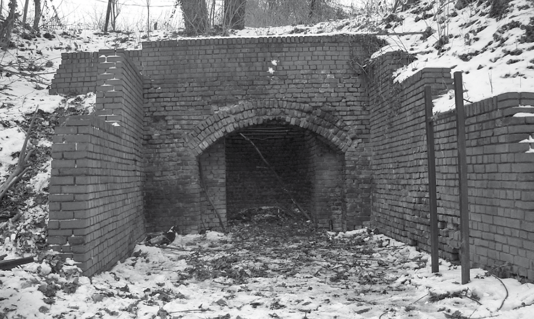
De in 1984 gerestaureerde en thans door kampvuren geteisterde oven.
