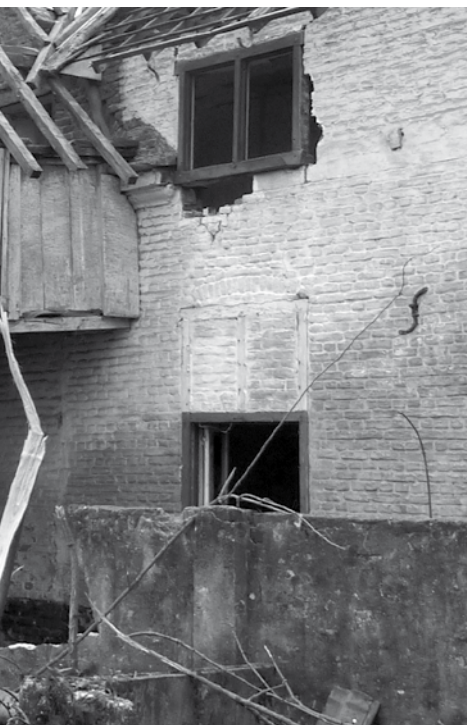
De in 2011 gesloopte vleugel met houten kruiskoorn met dichtgezet bovenlicht. Foto: onbekend
