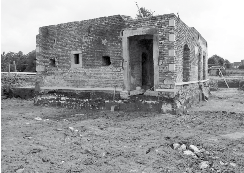
Aanzicht achtergevel tijdens de restauratie in 2012. Foto: Hermi Boosten
