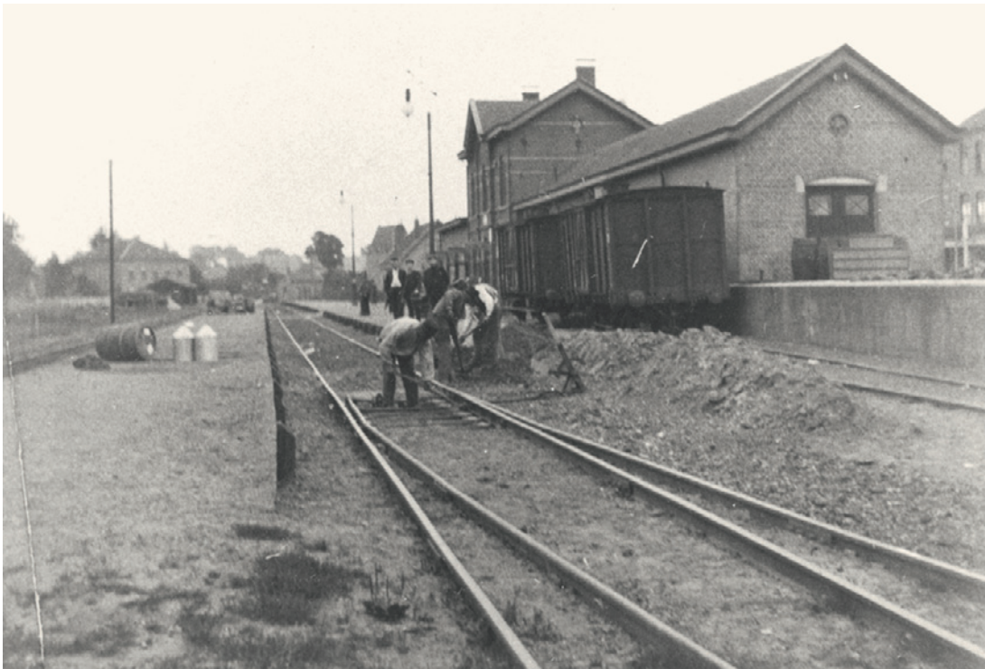
Werkzaamheden aan het spoor, 1907.
