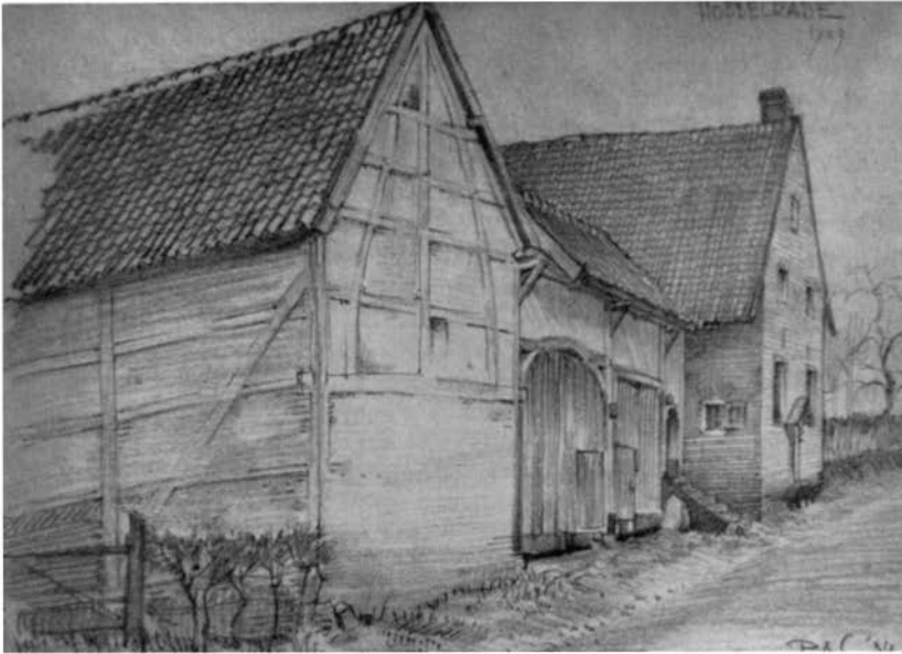
Afb. 4. Vakwerkhoeve te Hobbelrade. Het woongedeelte is in baksteen naar voren gebouwd.
