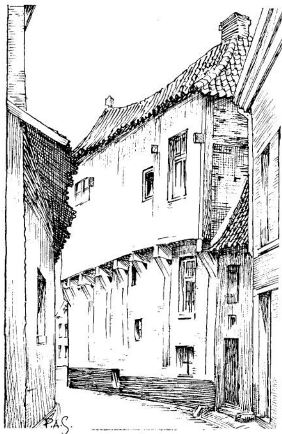
Afb. 24. Vakwerkgevel onder pleisterwerk, hoek Markt-Gats te Sittard.
