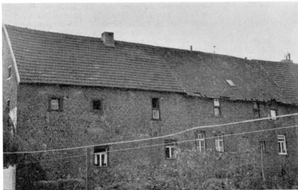
Achterzijde Hoeve de Vrank.
