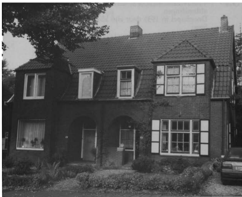
Bergstraat 11-13. Het pand rechts heeft nog de oorspronkelijke raamverdeling en de ronde bol bij de ingang.
