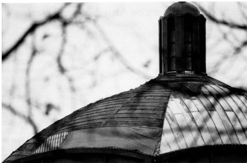
Beeld van de werkzaamheden aan het dak van de Annakerk in het najaar van 1989. Foto: Atelier 3 Poot.
