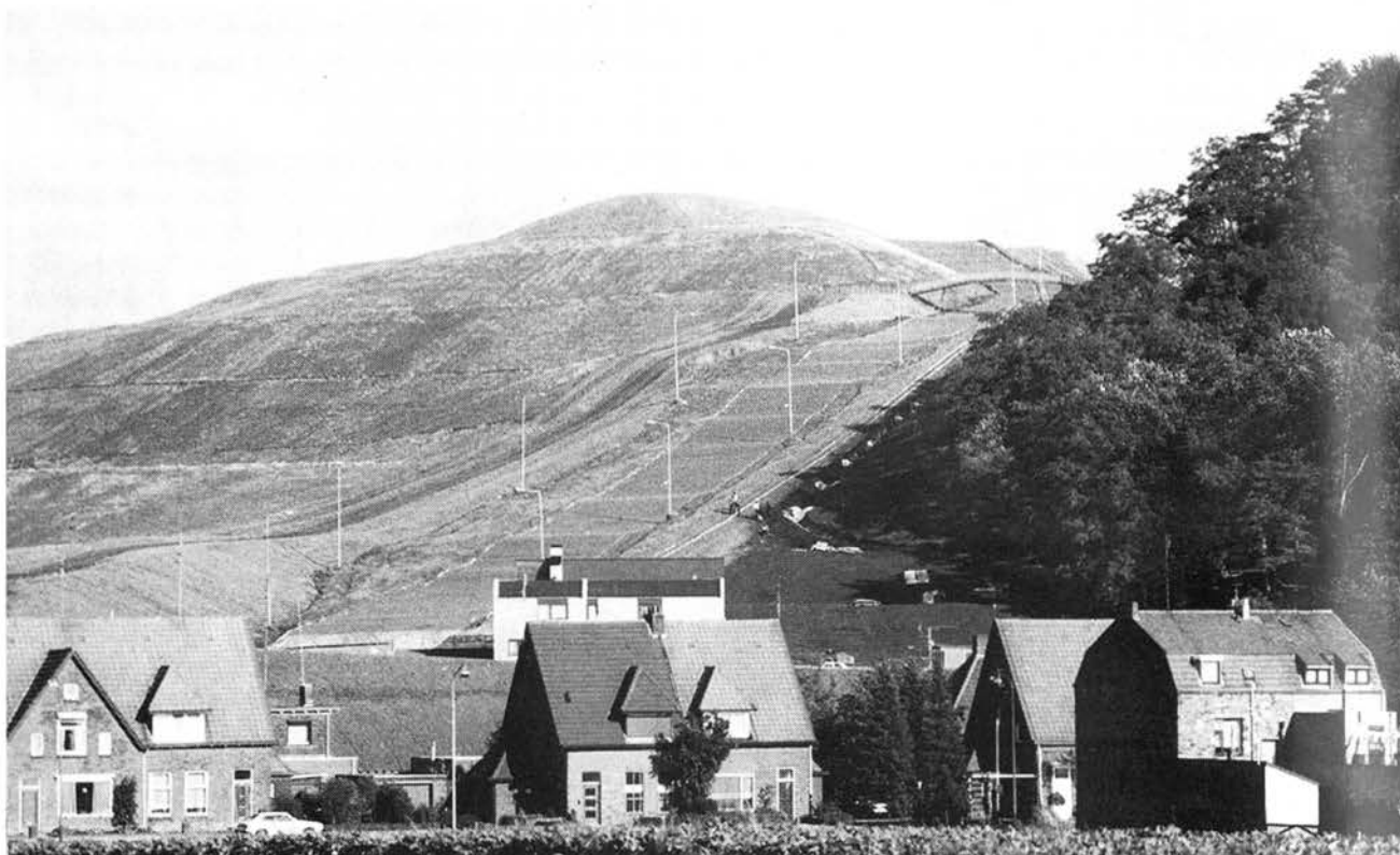
De plannen voor de aanleg van een skibaan zijn nu definitief.
