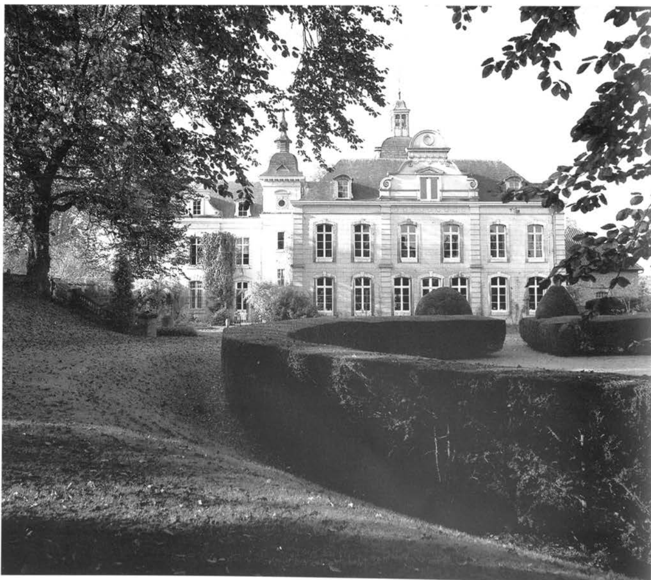
Kasteel Vaalsbroek heropent na een grondige restauratie.
