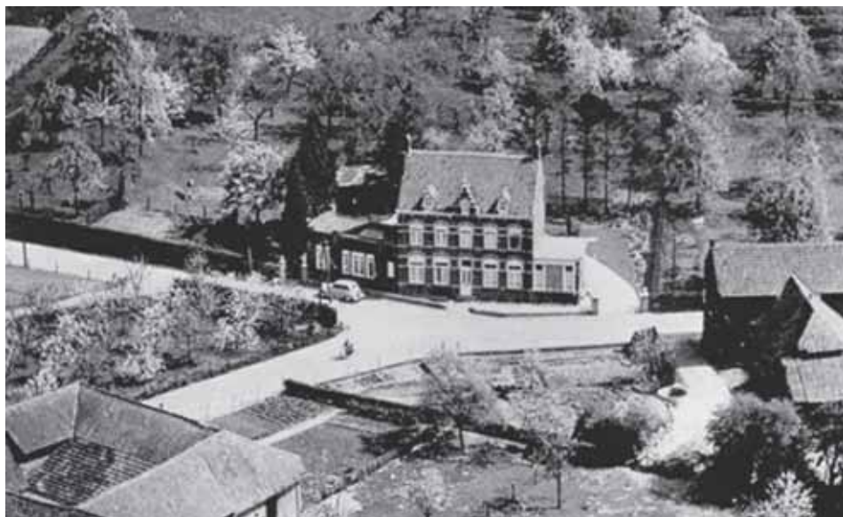
Pand aan de Steenweg.
