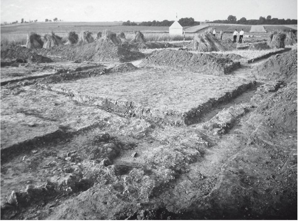
1. Het blootgelegde fundament van de Romeinse villa te Vlegendaal, opgegraven in 1912. De werkmannen zijn op de achtergrond te zien, evenals de tent voor de leider van de opgraving. Hier is goed te zien dat alleen de muurfundamenten werden blootgelegd. Bron: RHCL, Collectie Goossens
