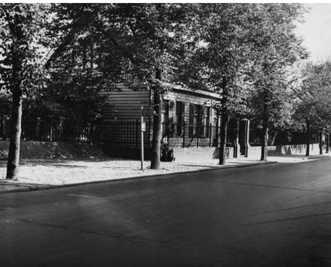
De dienstwoning van de hoofdopzichter Weg en Werken aan de Stationstraat. Foto: collectie Rijckheydt, Heerlen
