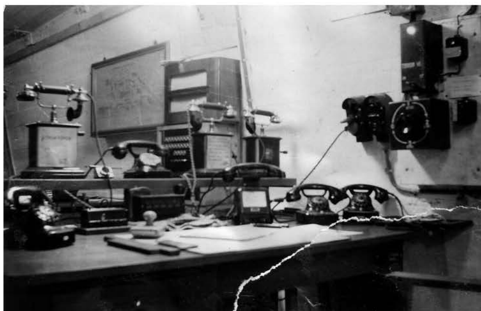
De telefooncentrale van de Luchtbeschermingsdienst van de Staatsmijn Emma in de leermijn, die korte tijd intensief gebruikt werd door de ID 18.
