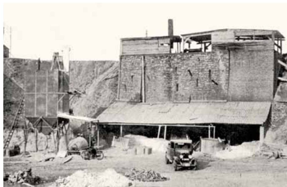
De Kalk-Mergel-Steen-Industrie: oven, blusinrichting en poederkalksilo. 31 Foto: Collectie J. Evers
