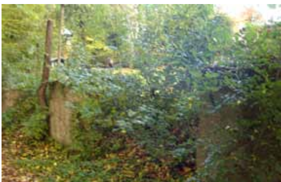
Het door Schunck in 1951 gebouwde kantoor. Duidelijk zichtbaar zijn de verschillende toepassingen van de kalksteen in metselverbanden. Daaronder de bouwtekening en onder de betonnen pijlerfundering van de transportbanden. Op het hierachter gelegen terrein bevinden zich nog de betonnen pijlers waarover de transportband liep en de restanten van de werkplaats. 42 Op de volledige tekening van de bouwvergunning voor de draaioven uit 1947 staan dezelfde soort funderingen getekend. Foto's: auteur
