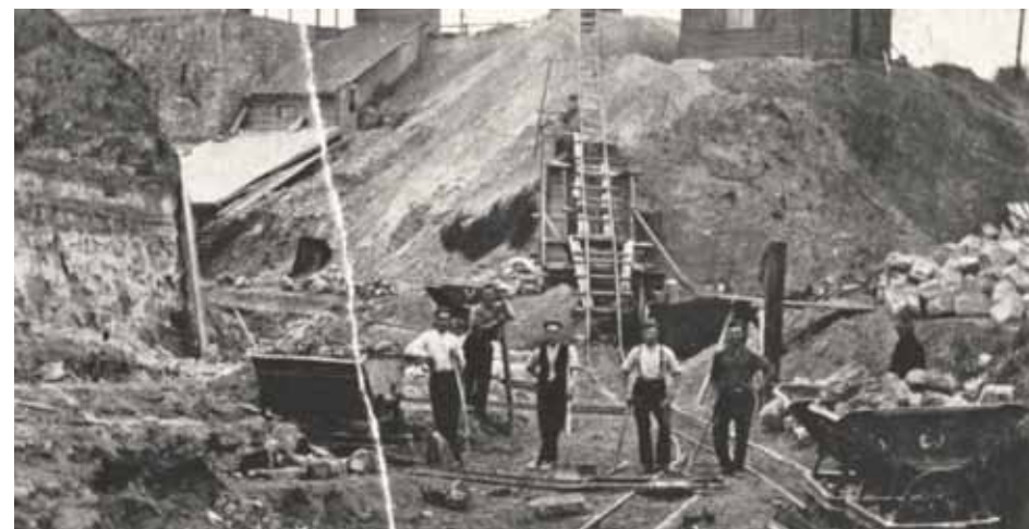
Arbeiders in de groeve Schunck met kiepwagentjes op smalspoor met wissel. Foto: Collectie J. Evers
