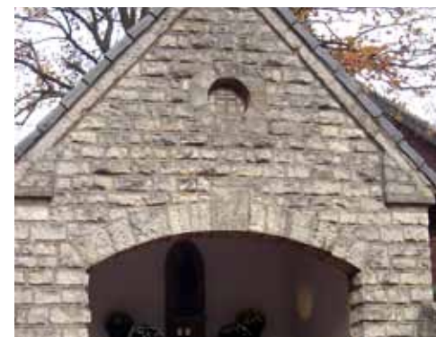
Detail van "het boogwerk" van de kapel te Colmont, met kalksteen afkomstig uit de groeve van Schunck. Foto: auteur
