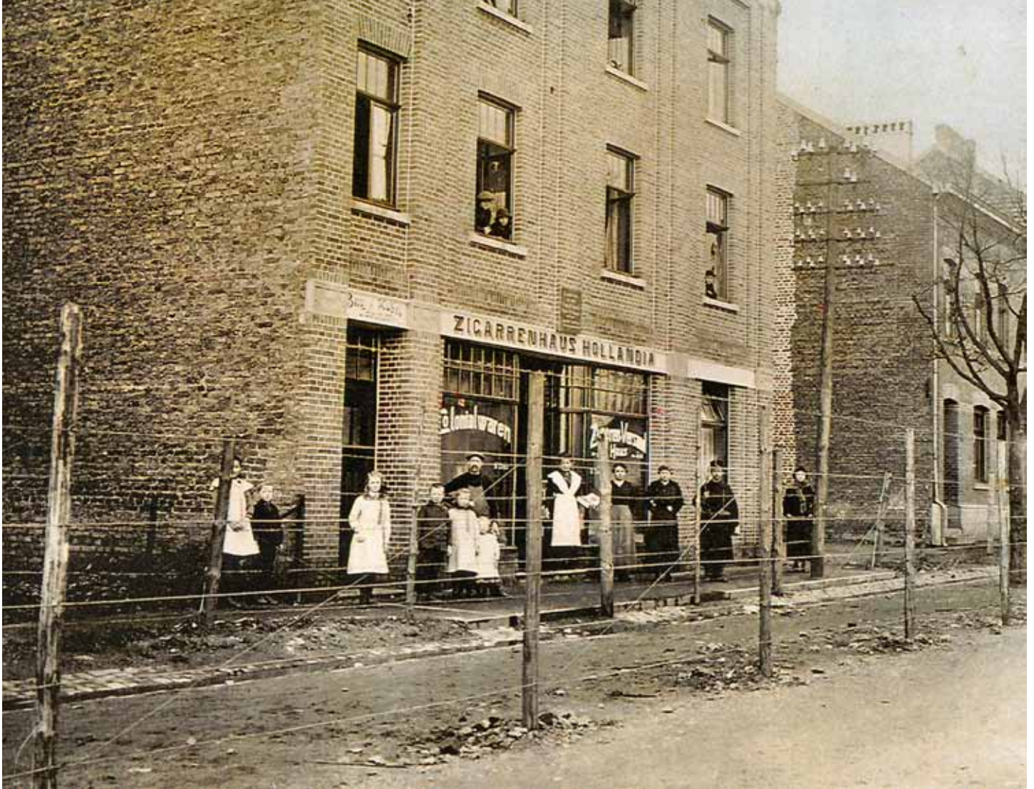
De aan het begin van WO I aangelegde prikkeldraad-/stroomdraadversperring aan de Nieuwstraat bij Zigarrenhaus Hollandia, het woonhuis van de familie Dols, december 1915.
