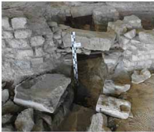
Cloaca voor en na: De latei (afsluitsteen) van de cloaca (afvoergoot) aan de westkant van het badhuis is door de restauratie op de oorspronkelijke locatie teruggemetseld.
