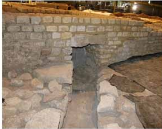
Cloaca voor en na: De latei (afsluitsteen) van de cloaca (afvoergoot) aan de westkant van het badhuis is door de restauratie op de oorspronkelijke locatie teruggemetseld.
