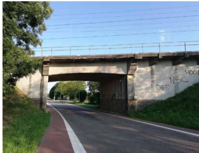
Viaduct tussen Klimmen en Voerendaal dat de Groep Smit wilde opblazen.
