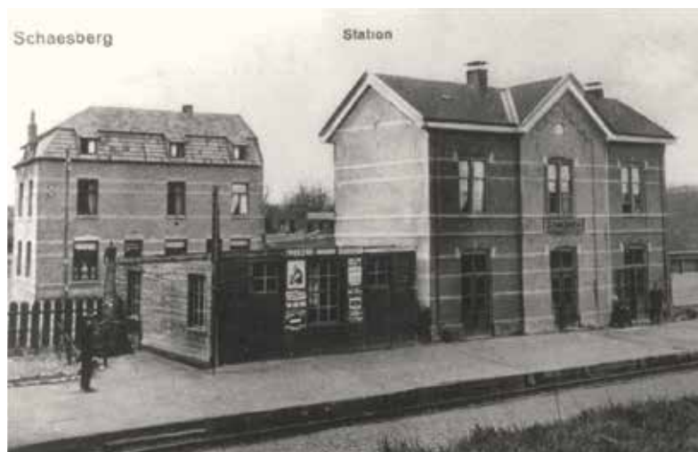
Het station van Schaesberg met houten wachtlokaal voor de mijnwerkers. Foto: Collectie Rijckheyt, Heerlen
