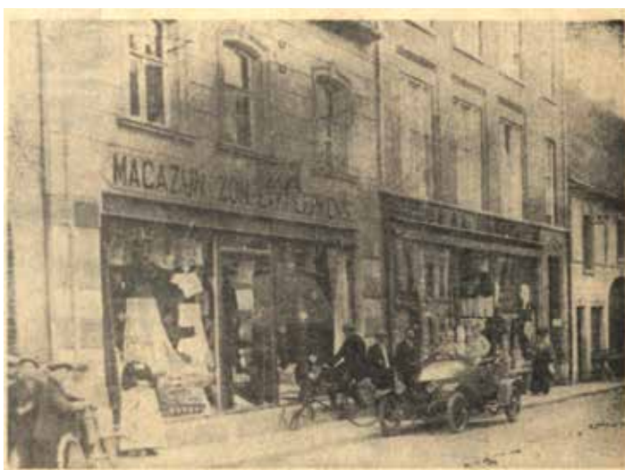
Magazijn 'De Zon' aan de Akerstraat in Heerlen na de aanbouw (rechts) in 1912. Het linker pand wordt in 1920 afgebroken. ( Limburgsch Dagblad , 6-4-1957)
