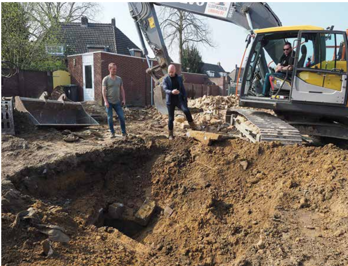
Hans van der Broeck (projectleider Weller), Wiel Dautzenberg (KSB, directievoerder wijkvernieuwing Oude Egge) en graafmachinist John Toering (Sloopwerken Limburg) bij de ingang van de ondergrondse schuilkelder. Foto: Bert van Ogtrop.
