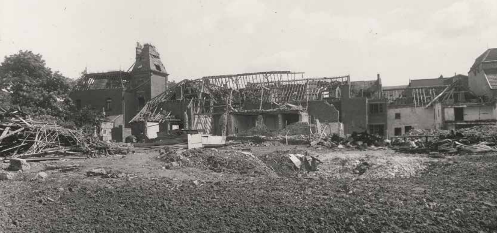
Beeld van de schade aan de huizen in de Willemstraat na het bombardement op 26 februari 1943. Foto: Collectie Rijksheyt, Heerlen
