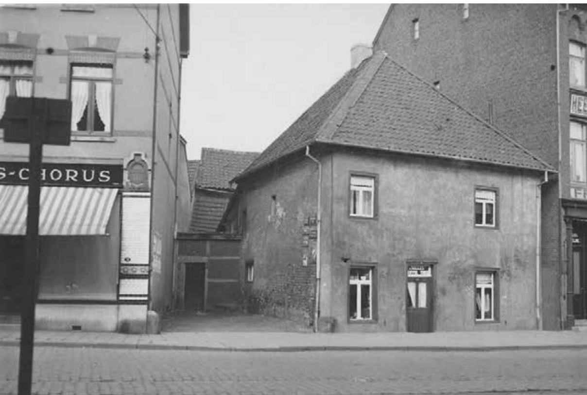
Huis van de rabbi aan het Wilhelminaplein. Op de achtergrond de toegangspoort naar de synagoge met daarachter een deel zichtbaar van de synagoge. Collectie Rijckheyt
