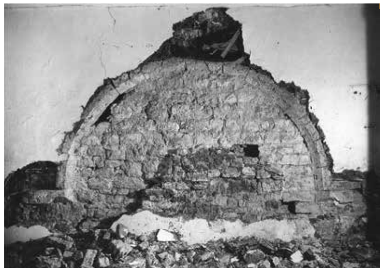
De blindboog bij de ontdekking tijdens de restauratie van de gerechtskamer in 1975. Collectie: HCL-Rijkheyt
