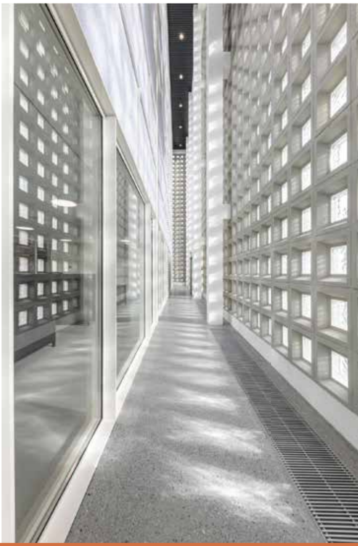
Ruimte tussen de buiten- en binnengevel, tussen de 'doos en doos'. Foto: Klaus Tummers
